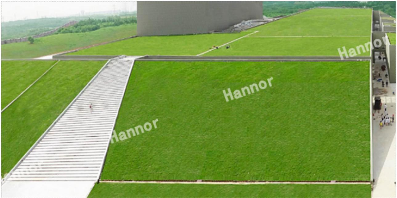
屋顶花园所选的园林小品及公用设施设计：（1）园林小品及公用设施应遵循公园设计规范。（2）园林小品及公用设施应设置在建筑墙体、承重梁位置，高度不得大于3米。园林小品及设施应选择质轻、环保、安全、牢固材料。（3）为防止高空物体坠落和保证游人安全，应在屋顶四周设置防护围栏，高度应130cm以上。（4）花园式屋顶绿化照明设计应选用具有诱灭虫功能的灯具。（5）园林小品建筑的基础不得破坏屋顶防水层。（6）排灌系统设计6.1屋顶绿化排水系统必须与原屋顶排水系统匹配，不得改变原屋顶排水系统（天沟）。6.2种植池、花台等必须根据实际情况设置排水孔，应根据排水口设置排水观察井。6.3屋顶绿化灌溉设计应优先设计自动喷灌、滴灌装置，预留人工浇灌接口。6.4屋顶绿化应设置出入口和安全通道，必要时应设置专门的疏散楼梯。
